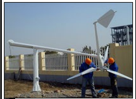
Fig 8(d) Tiltup tower
